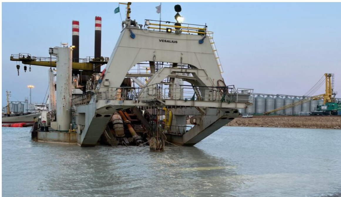
Рисунок 36. Дноуглубительные работы в порту Курык (Мангистауская область) для обеспечения доступа крупнотоннажных судов 77
